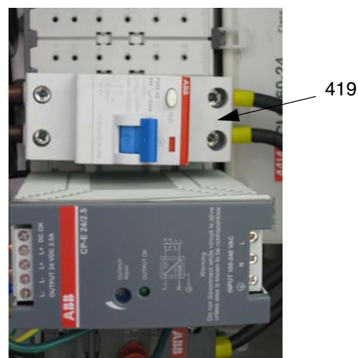
Рис. 31: Выключатель короткого замыкания на землю
